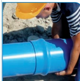
Плотно вставьте прямой конец в другую трубу. Протолкните трубу в раструб до маркировочной линии.
