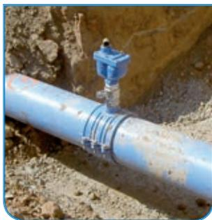
Хомут для врезки должен обеспечивать плотный контакт с трубой. Нельзя использовать хомуты универсального диаметра. Вместо этого необходимо применять специальные хомуты для ПВХ под определенный номинальный диаметр.
