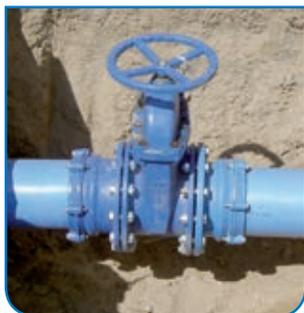
Система противоскольжения позволяет плотно закрепить трубу на фланце.
